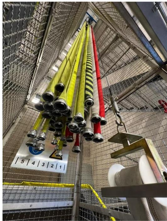
圖 22 電動吊掛水帶的裝置
