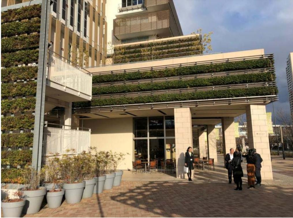
圖 7-13 柏之葉永續智慧社區建築物外牆設置植生牆及太陽能光電板
