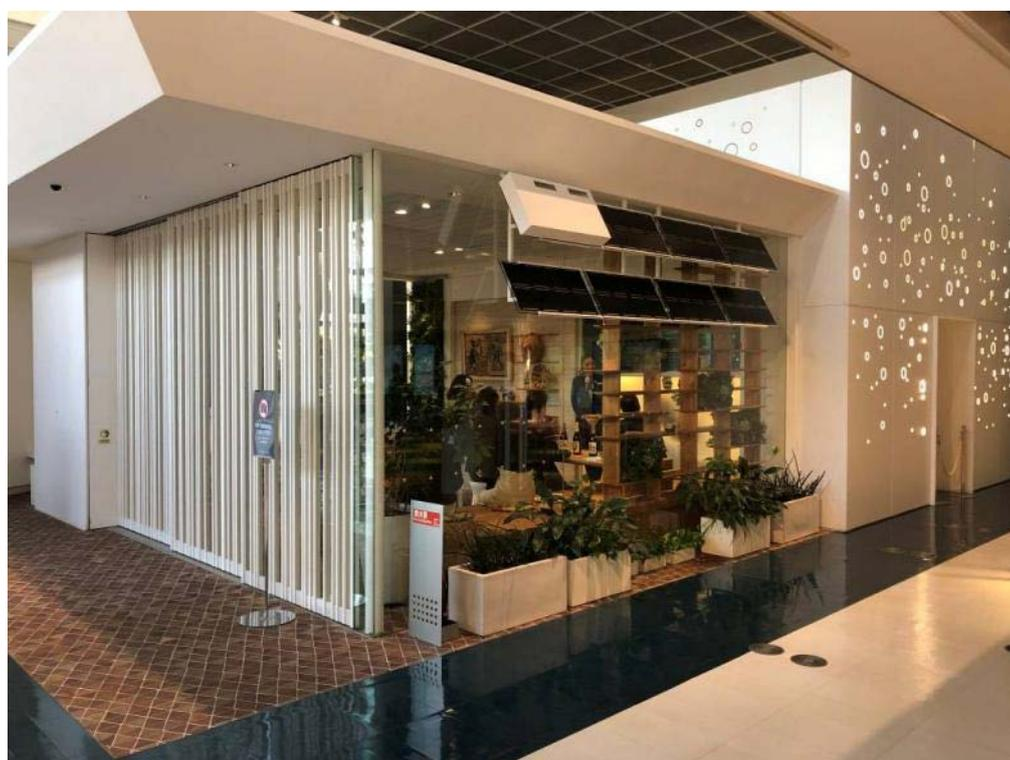
圖 6-6 戶外設置太陽能板兼具遮陽與發電功能
