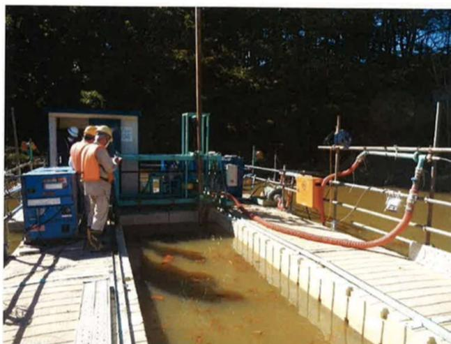
圖 20、利用浮板船進行儲水池淤泥的除污作業
