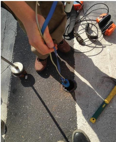
圖 4.4.3 將噪音記錄器置換為聽音器
