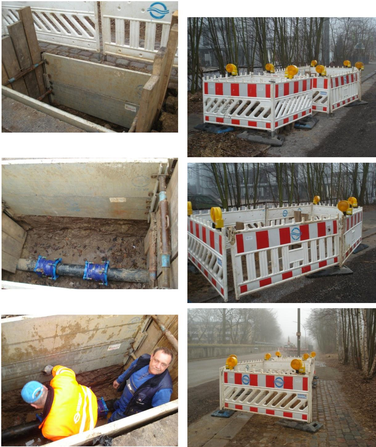
圖 18 漢堡水務施工擋土設施及安全護欄
