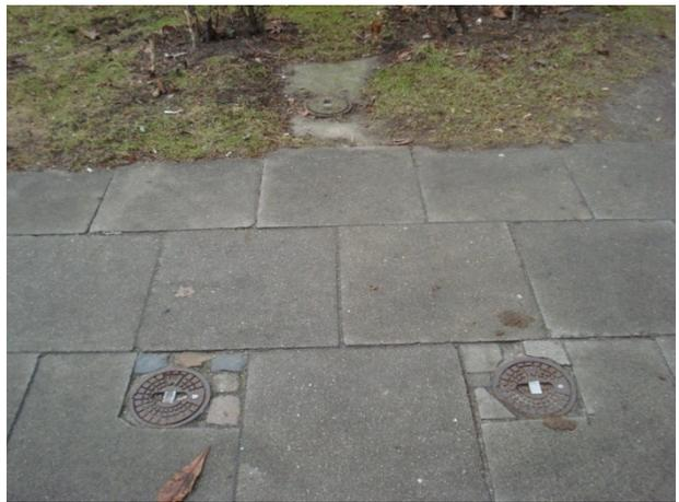
圖 17-2 漢堡水務制水閥埋設口徑及位置標示
