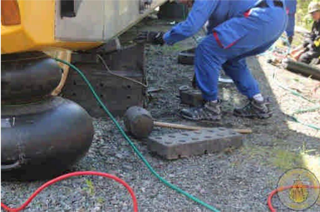
圖 4-1-9 塞入墊塊以達雙重確保的效果
