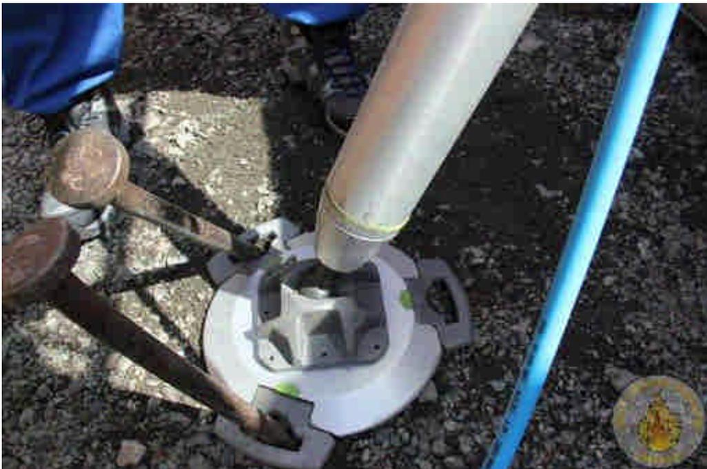
圖 4-1-7 地面的承重板打入鋼釘以防止其水平移動
