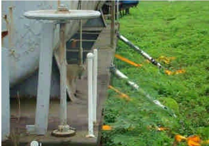
圖 7-5 緊固帶與支撐柱穩固車體
