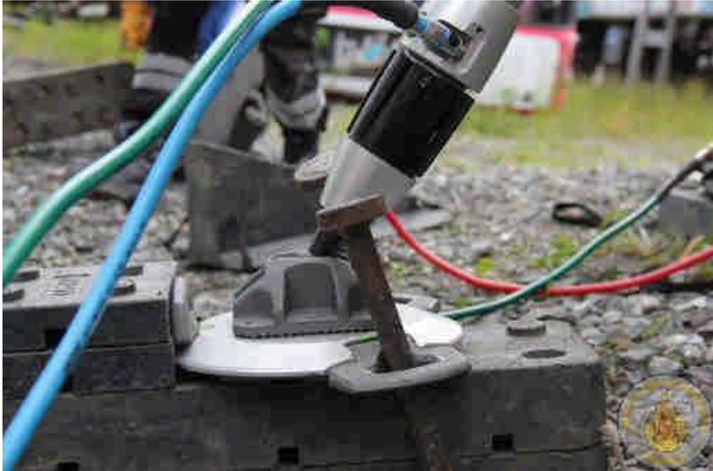
圖 4-2-9 地面的承重板打入鋼釘以防止其水平移動
