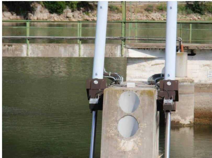
圖 17 油壓缸露出於水面拉伸控制閘門
