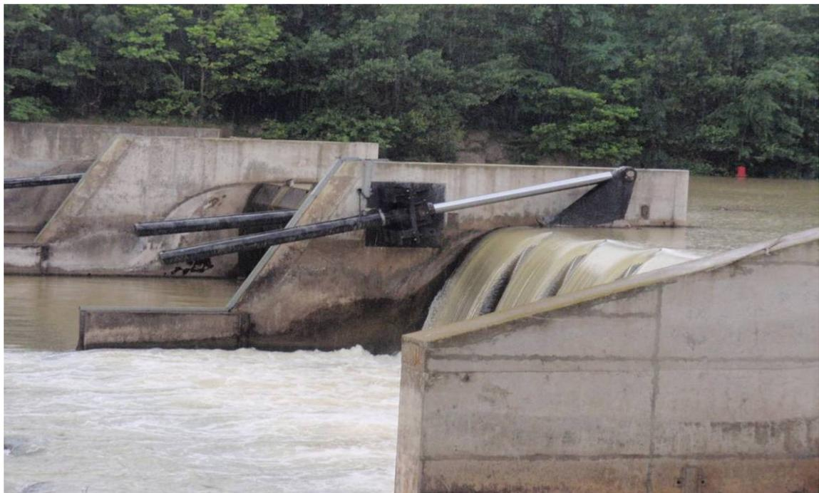
圖 20: 採單邊作動控制閘門啟閉之 Pont Rouge dam
