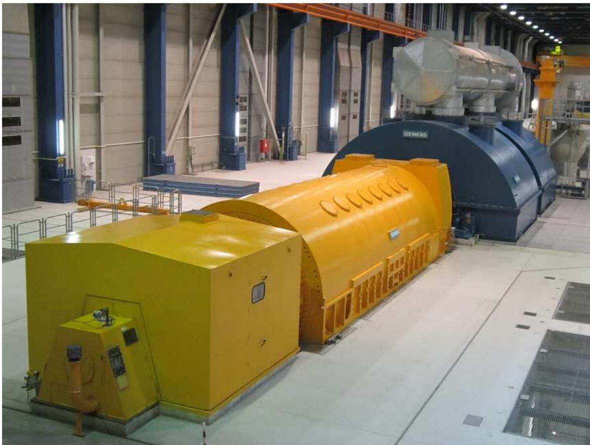
圖(30)Schwarze Pumpe Power Plant 汽機及發電機
