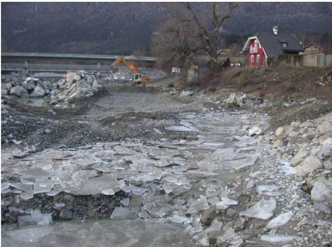
圖 9-4 茵斯特與機場臨近河川正在施工中邊坡砌石工程
