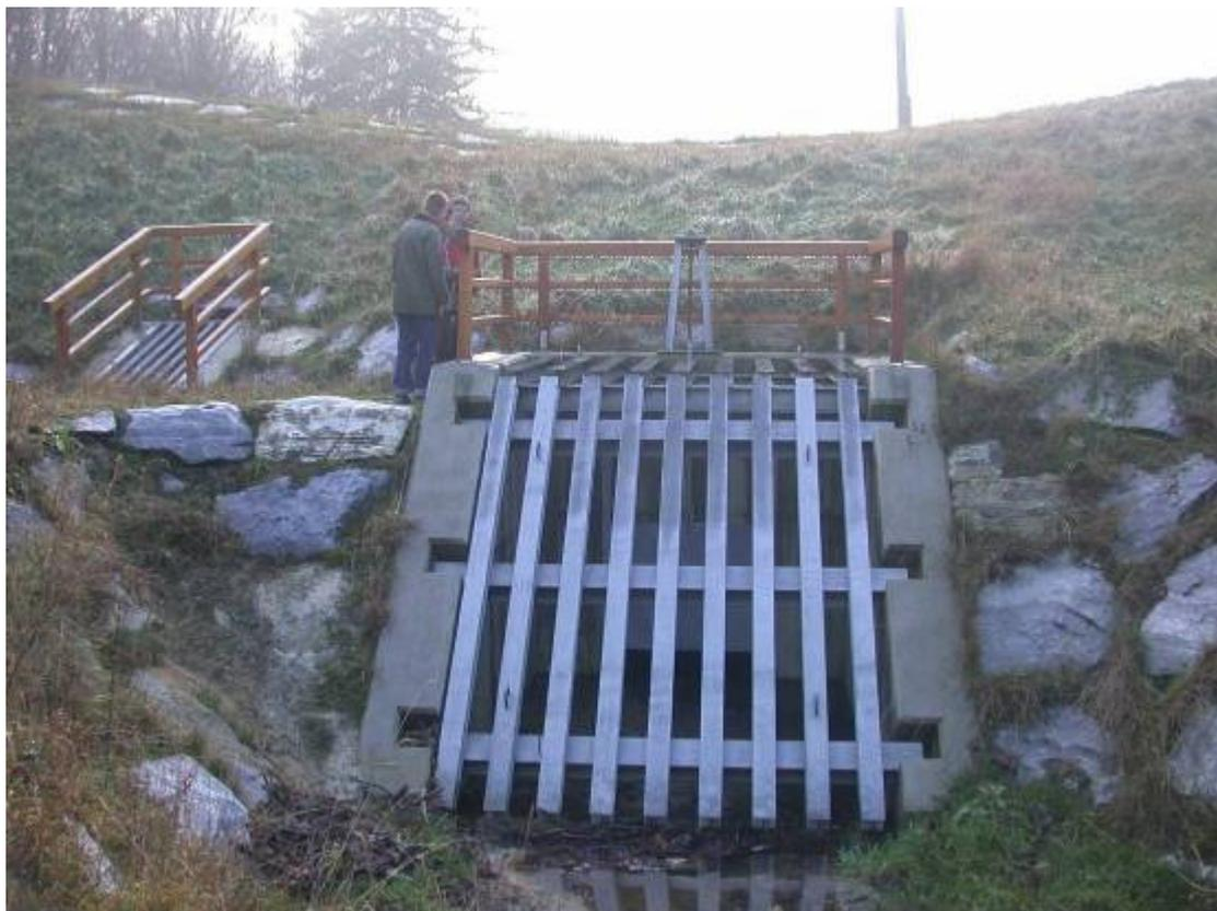
圖 3-1 維也納山區已完工預防性控制策略攔砂壩（上游面）
