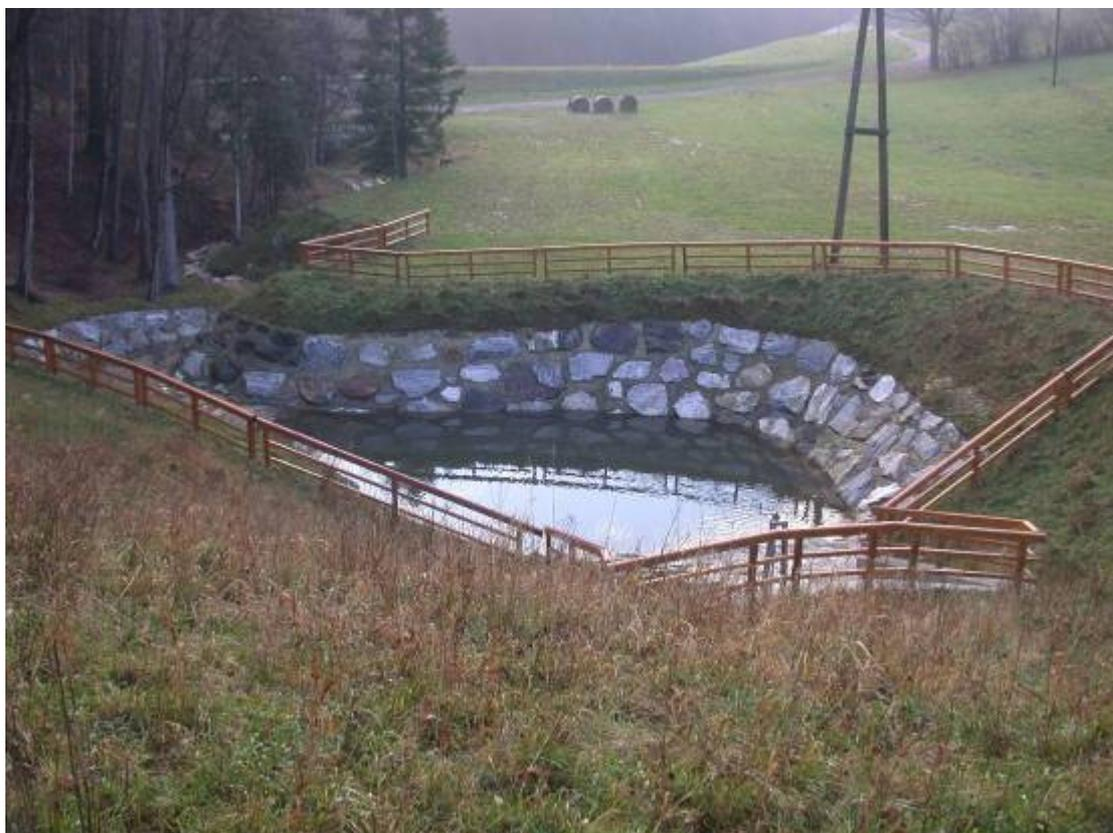
圖 3-2 維也納山區已完工預防性控制策略攔砂壩（下游面）
