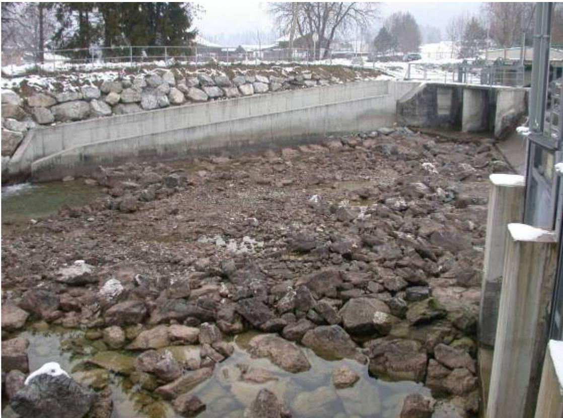
圖 9-8 茵斯特與德國臨近地區一處取水口設置魚道工程
