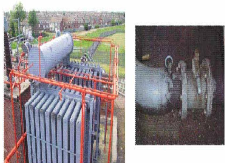
圖 3.30:浸油變壓器外箱、油密洩漏狀態
