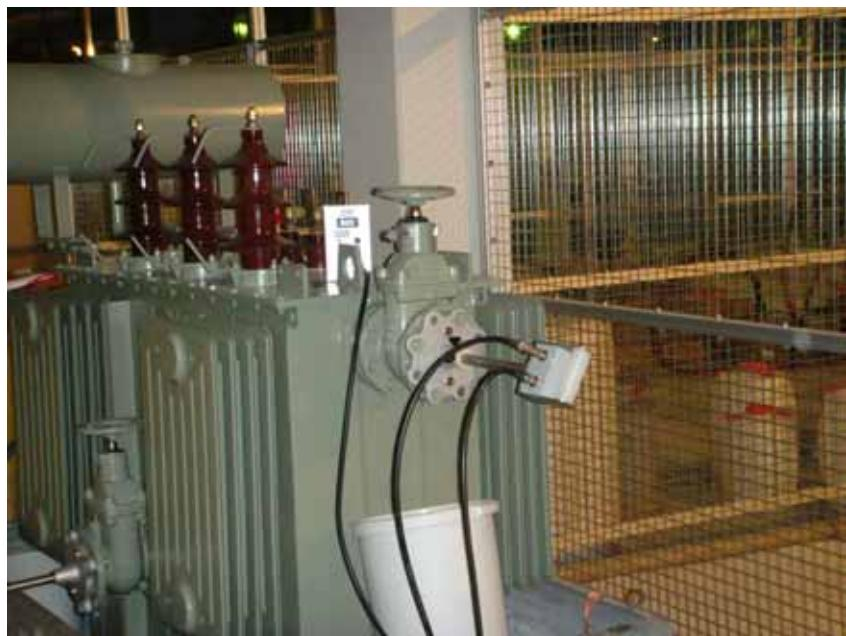
圖 3.10:超音波/超高頻傳感器耦合檢測應用
