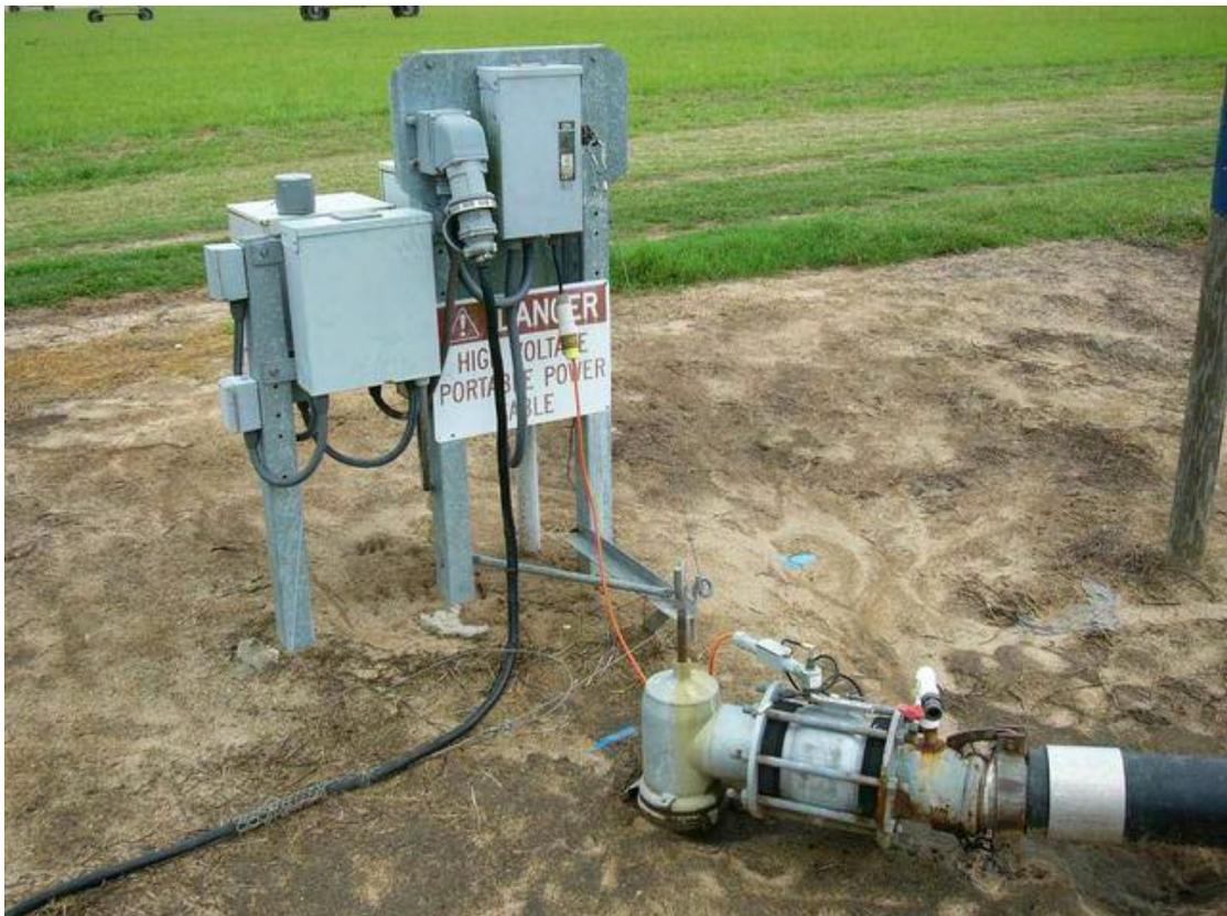
圖3-11 Liner Pivot供水及供電設施
